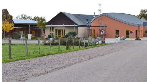
Figure 24 : École de Saint-Éloi – Réalisation DORGAT
